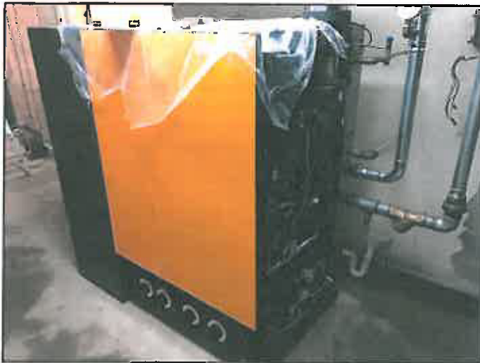
Kesseltausch an der Schule Onolzheim im August 2019
