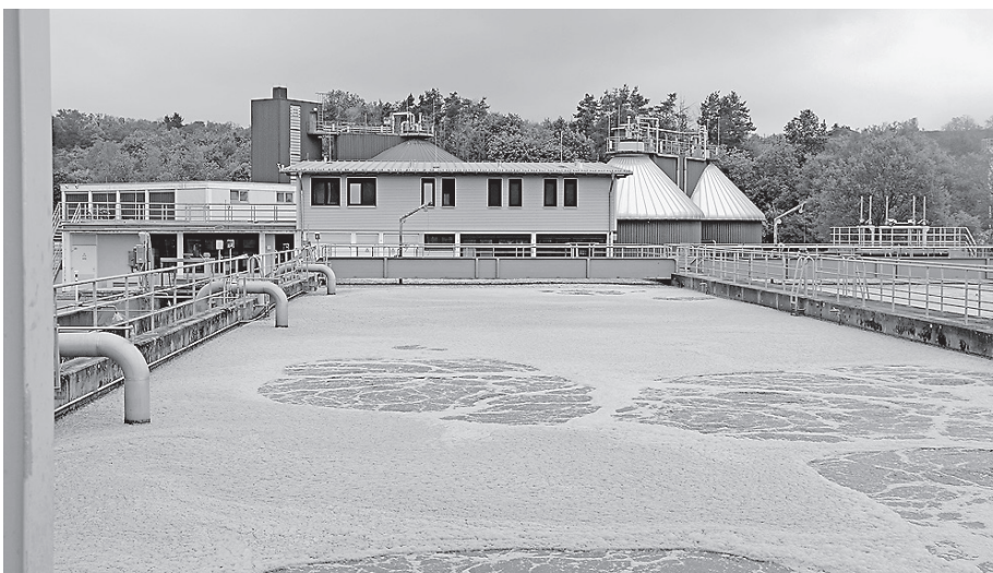
Das Belebungsbecken ist die biologische Stufe: Hier übernehmen die Bakterien die Arbeit.
