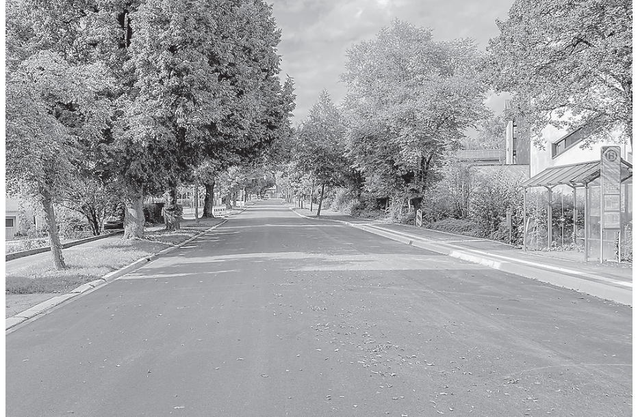
Der Straßenbelag ist saniert, die Markierungen wurden nach der Öffnung aufgebracht. Foto: Stadtverwaltung
