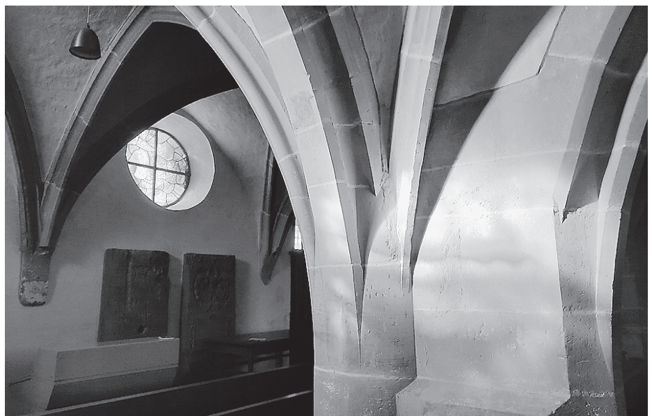
Am kommenden Freitag findet ein Rundgang durch die Johanneskirche statt, welcher sich mit den eindrucksvollen Glasfenstern der Kirche beschäftigt. Foto: Stadtverwaltung
